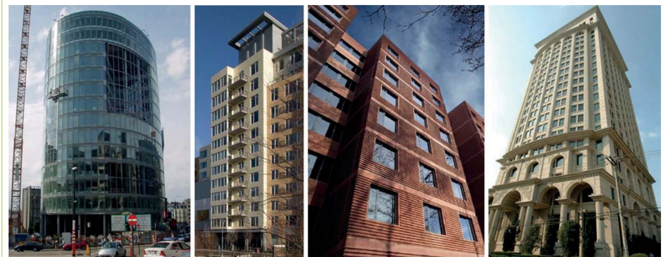
> Figura 1: Edifícios pré-fabricados em betão (Bruxelas, Massachusetts, New Jersey e São Paulo) [3, 6].
